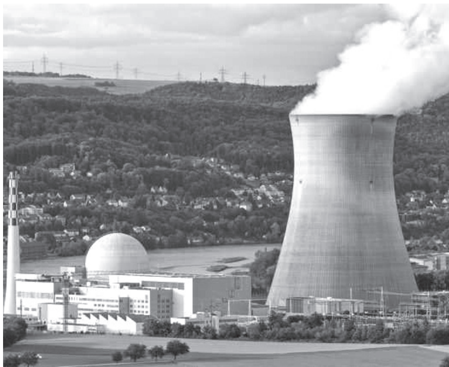
Расми 27. Нерӯгоҳи барқи атомӣ
